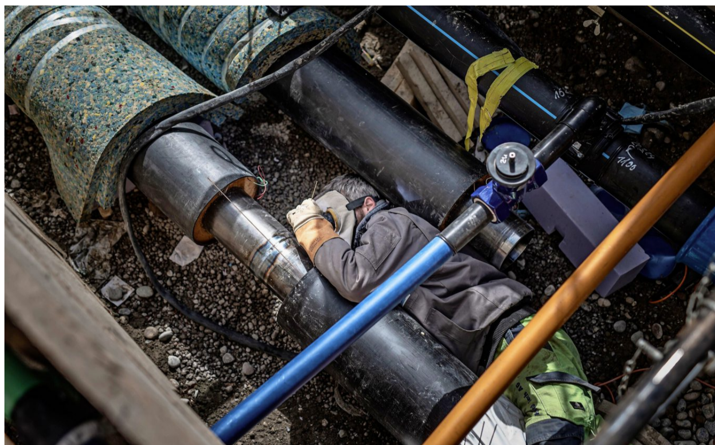
Ein Arbeiter verlegt eine Fernwärmeleitung. Das Fernwärmenetz wird auch in St.Gallen kontinuierlich ausgebaut. Symbolbild: Michel Canonica
