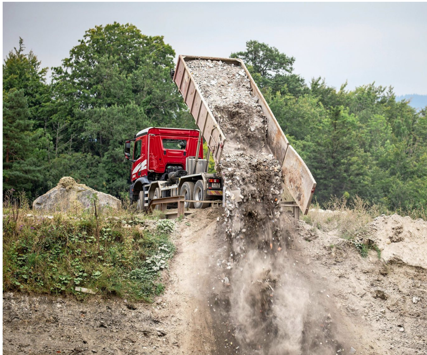
Ein Lastwagen entsorgt Schutt in der Deponie Tüfentobel.
