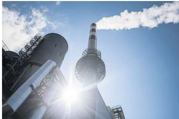
Dem Hochkamin der Kehrichtverbrennung im Sittertobel entströmt in erster Linie Wasserdampf. Bild: Benjamin Manser (9. August 2017)
