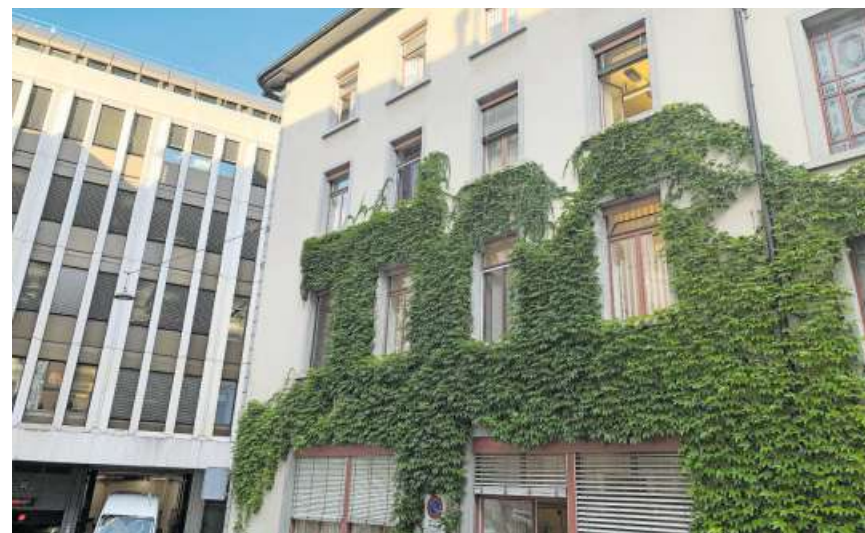
Begrünte Fassade am Bürogebäude der Technischen Betriebe: Die Stadt will ein gutes Beispiel abgeben.
