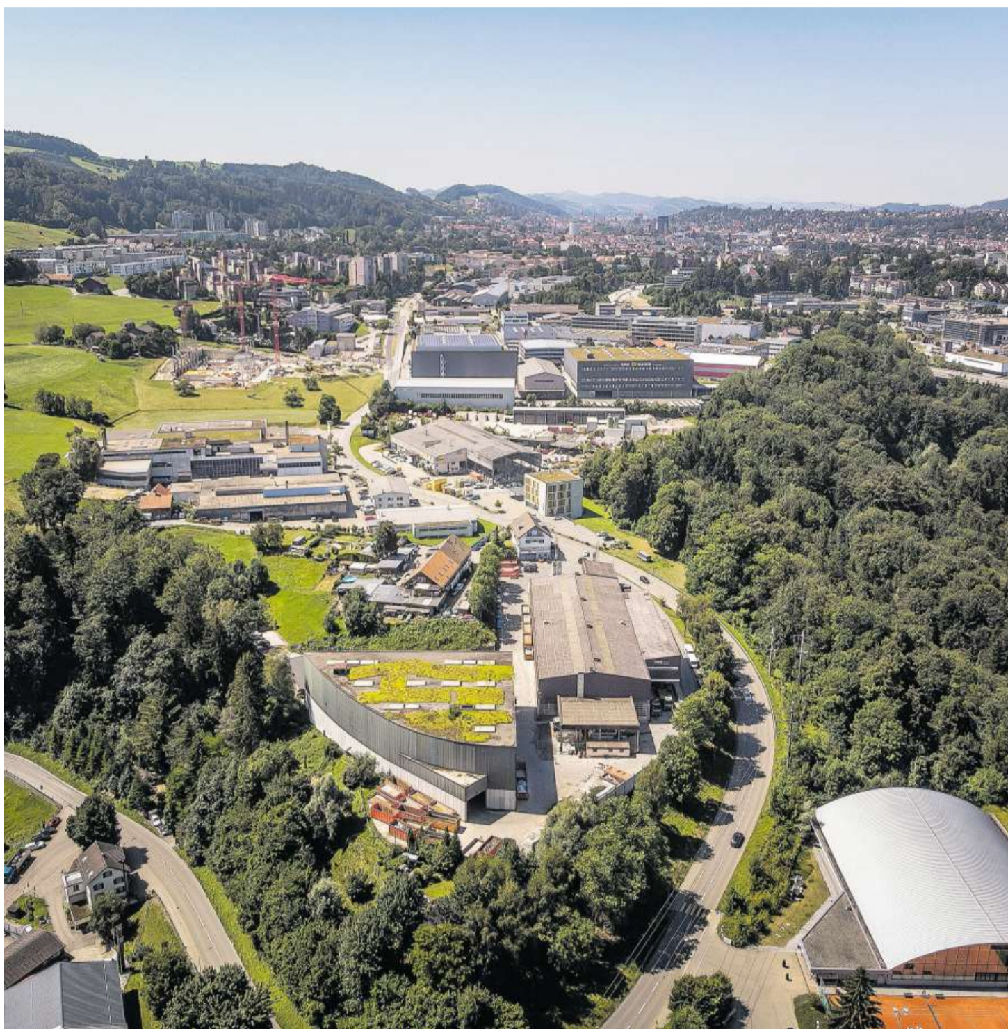
Das Altholzheizkraftwerk soll auf dem Areal der Müllers-Entsorgung (im Vordergrund) entstehen.
