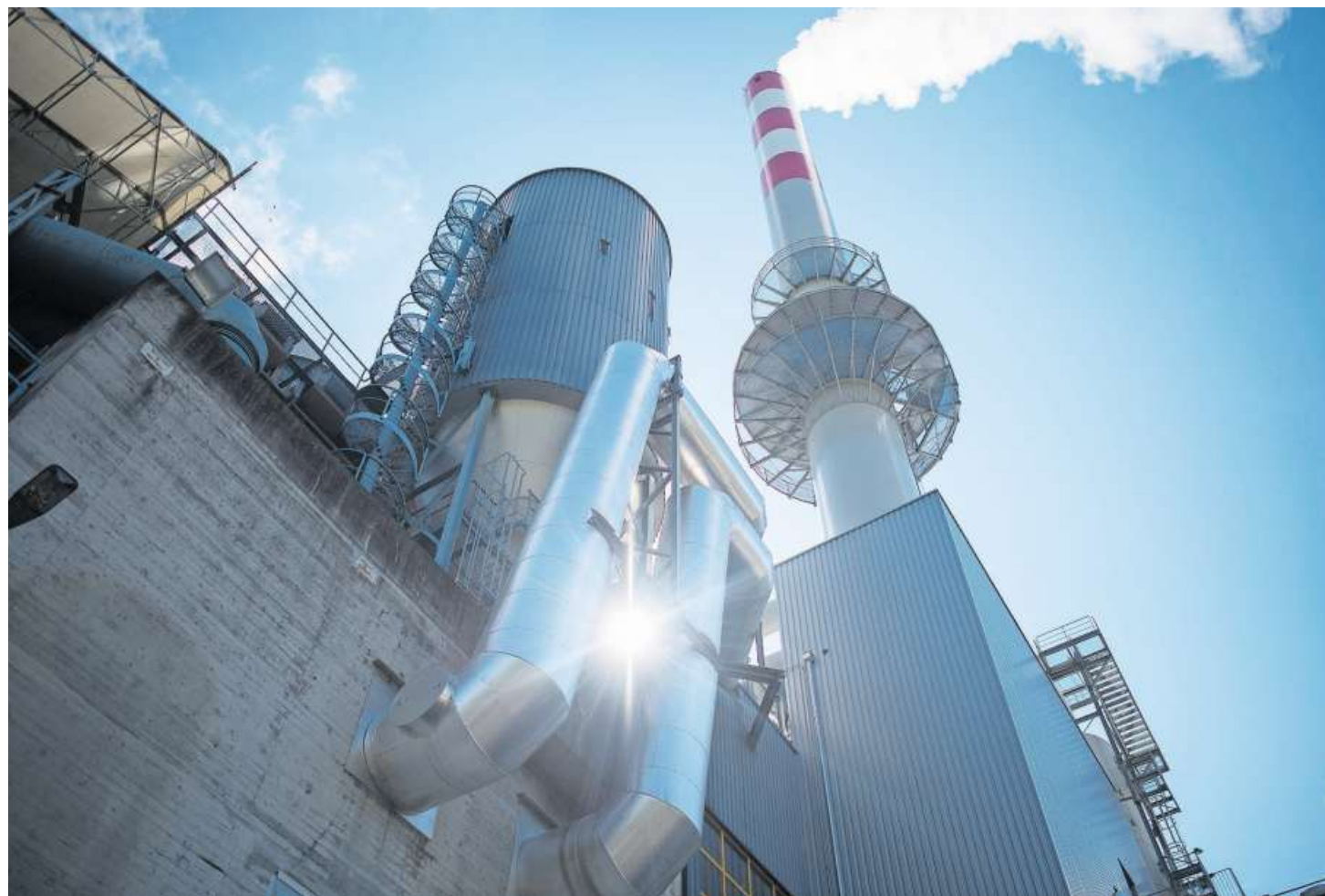
Das Kehrichtheizkraftwerk (KHK) im Sittertobel ist sozusagen der Brenner der städtischen Fernheizung.
