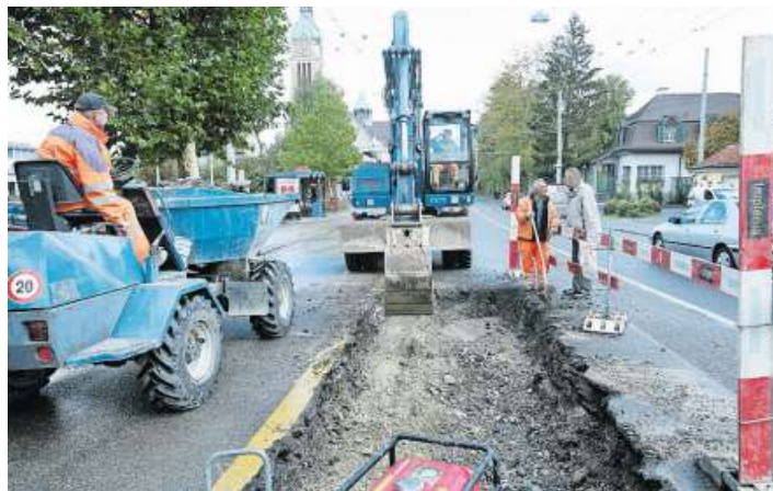
Viele St. Galler Wasserleitungen sind sanierungsbedürftig: Reparatur eines gebrochenen Rohrs im Neudorf. Bild: Ralph Ribi (11. Oktober 2016)
