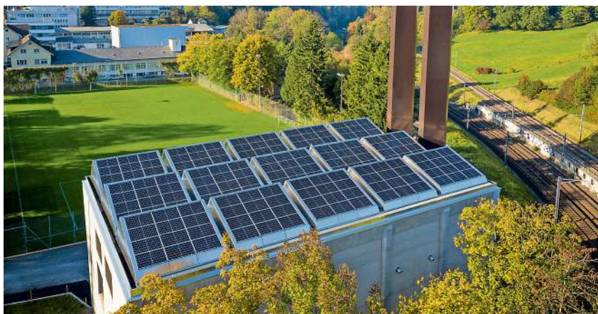
Die Fernwärmezentrale Lukasmühle.
