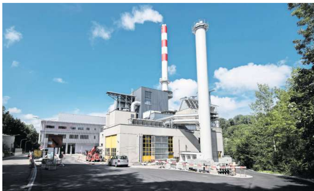
Im Kehrichtheizkraftwerk im Sittertobel wird der Grossteil der Wärme produziert. Bild: Benjamin Manser
