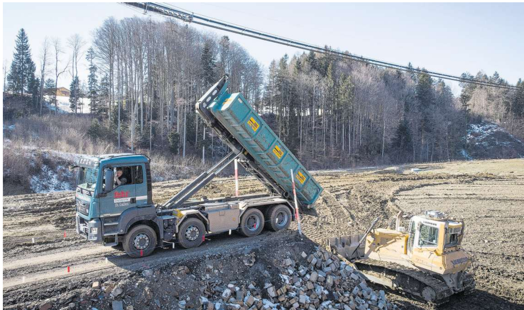
Wegen eines Rechtsverfahrens musste die Annahme von Aushubmaterial in der Deponie Tüfentobel zuletzt stark reduziert werden.
