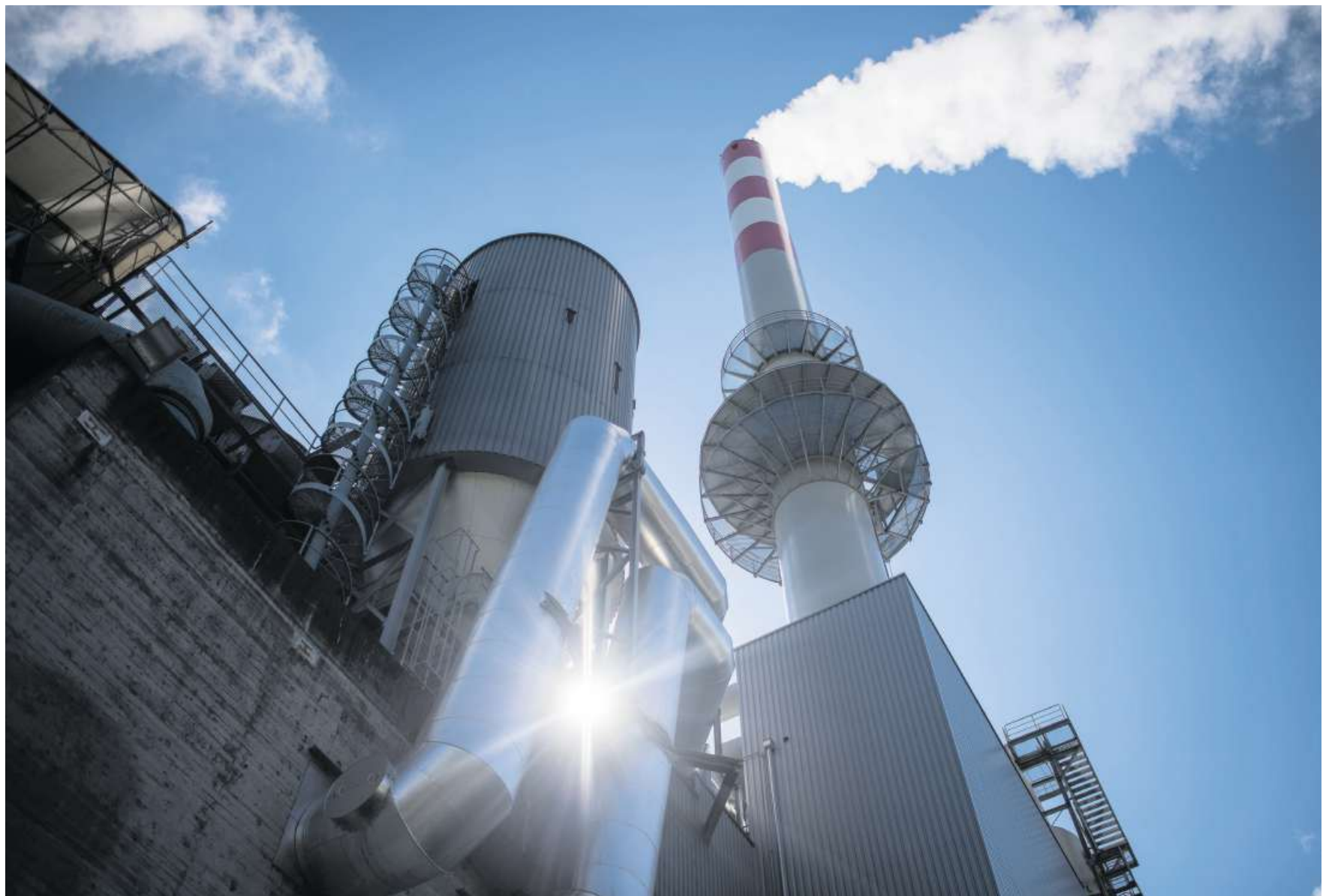
Im Moment liefern die Brennöfen des Kehrichtheizkraftwerks noch mehr Energie, als die Fernwärmekunden benötigen.
