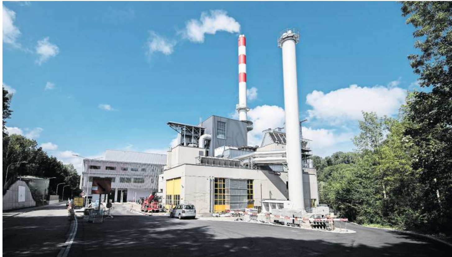
Die Wärme für das St. Galler Fernwärmenetz kommt zur Hauptsache aus dem Kehrichtheizkraftwerk im Sittertobel.
