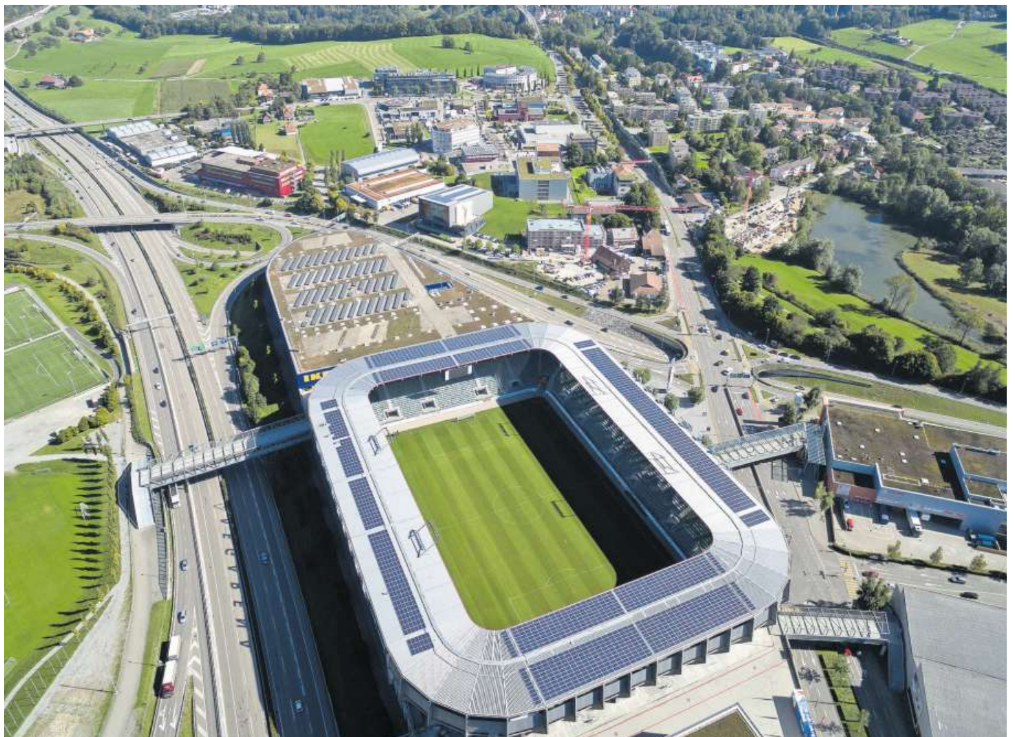
Auf dem Dach des Kybunparks befindet sich seit zwei Jahren die grösste Photovoltaik-Anlage der Stadt.
